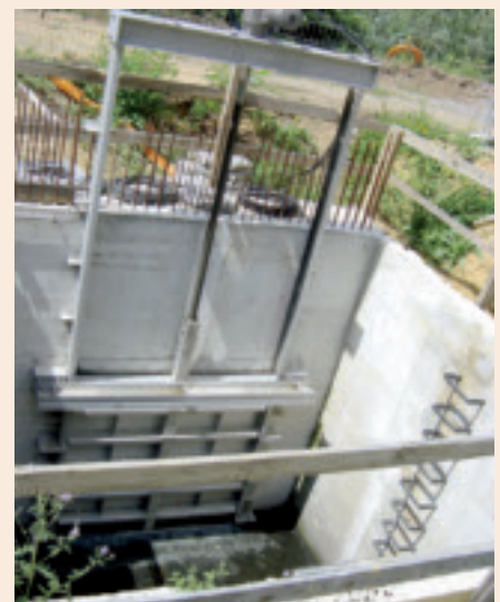
Ansicht des Hauptverteilerbauwerks mit zwei Schiebern.
