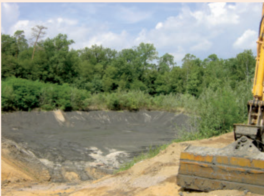
Die schwarze Masse an den Wänden von Becken 1 ist Schlamm, der den Abfluß des Sickerwassers erschwerte und ausgehoben werden mußte. Hier trocknet er an den Wänden des Beckens. Mittlerweile ist er entsorgt.
