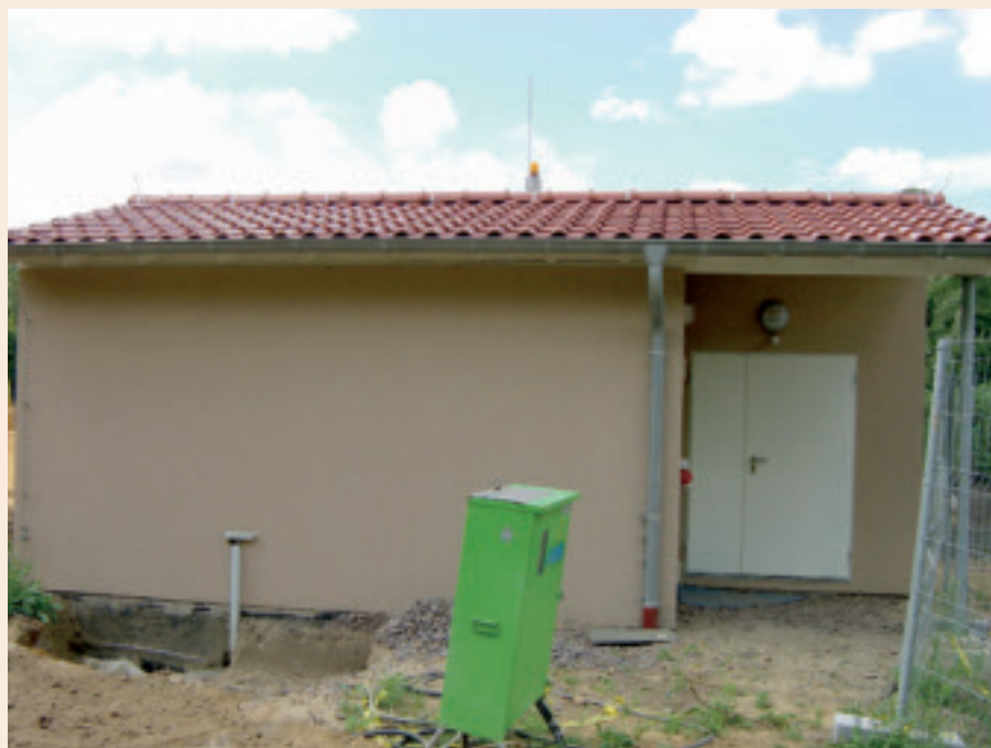
In diesem kleinen Gebäude ist die für die Sickeranlage benötigte Steuer- und Regeltechnik untergebracht.
