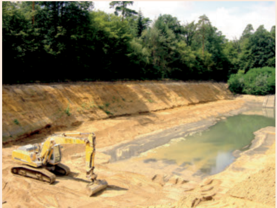
Der Schlamm in den Absetzbecken 2 und 3 ist beseitigt. Hier das Becken 3 mit dem die Hauptarbeit leistenden Bagger.
